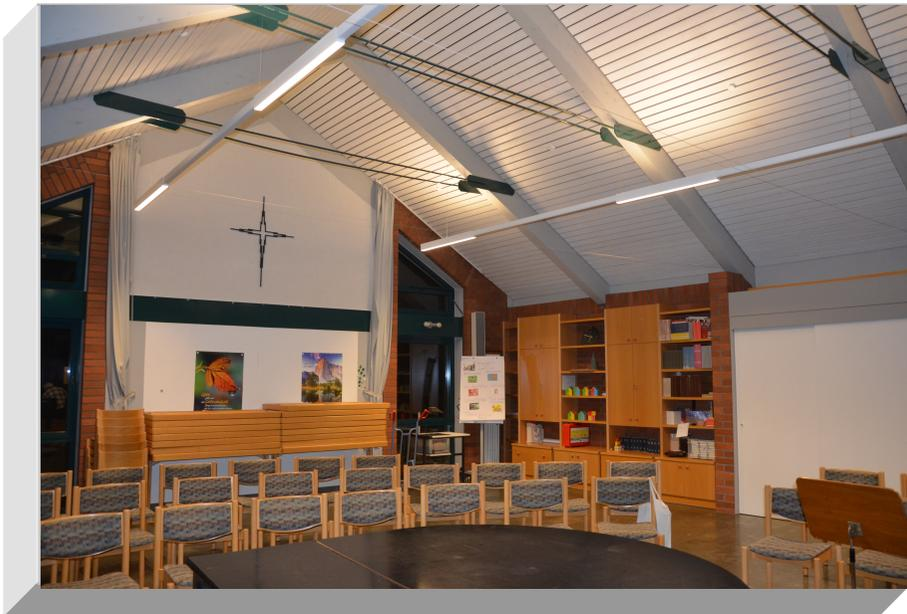
Für die längst fällige Erneuerung der Saalbeleuchtung ist die neueste LED-Technik unter Verwendung von direktem Licht für den Nutzungsbereich und indirektem Licht für die abgeschrägte Deckenkonstruktion eingesetzt worden. Die enorme Lichtausbeute verbunden mit einer Helligkeitsregelung und die warmweiße Lichtfarbe ermöglichen es, den Saal z.B. in einen Konferenzraum oder in einen Raum für Familienfeiern umwandeln.
